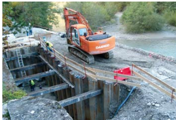
Les travaux de réalisation de la passe à poissons du seuil de Chaudanne
