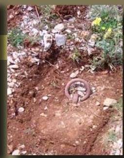
Cet anneau permet de soulever une dalle sous laquelle circule l'eau. On l'appelle un regard. Il permet de nettoyer le canal en cas de bouchon.
