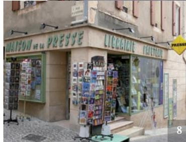
5. Devanture à large bandeau en coffrage de bois surmontant une fenêtre à deux volets et une vitrine pouvant être fermée par des vantaux repliables (Riez)
