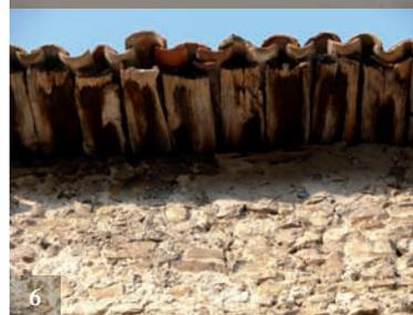
5. Génoïse à trois rangs formés de haut en bas d'un rang de briques creuses, d'un rang de tuiles rondes alternées avec des carreaux de terre cuite et d'un rang de briques creuses (Saint-Julien-le-Montagnier)
