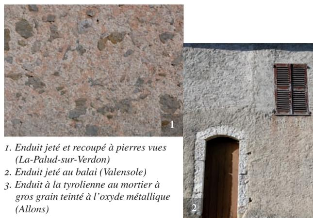
1. Enduit jeté et recoupé à pierres vues (La-Palud-sur-Verdon)
