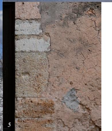
1. Maçonnerie de galets et chaîne d'angle\* harpée, formée de blocs équarris de pierre dure (Montagnac-Montpezat)
